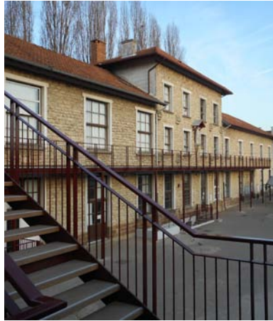
Clamart - O.G.E.C Restructuration et rénovation du collège Chantier en cours - Livraison 2018
